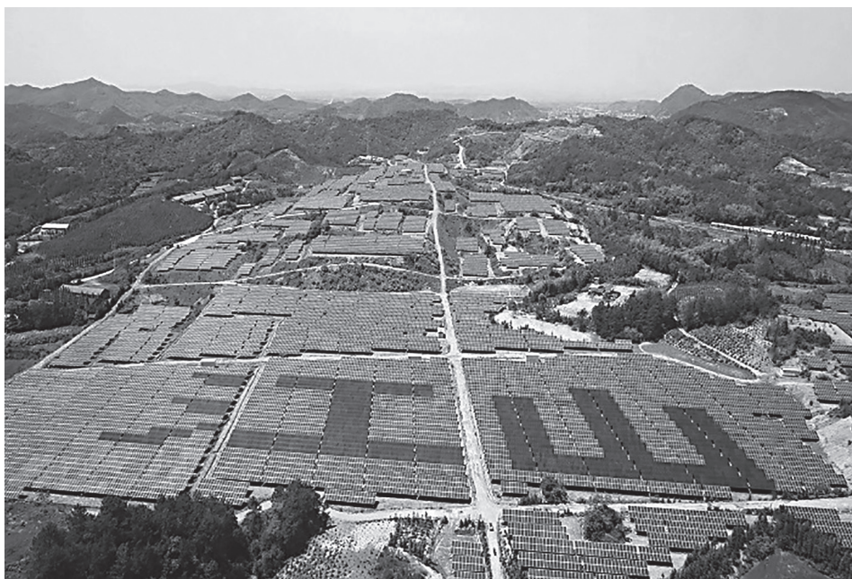
浙江江山200兆瓦林农光互补大型地面电站一角
