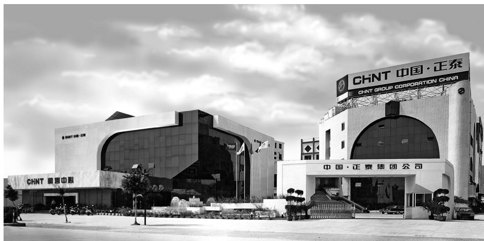
位于乐清柳市的正泰集团老总部
