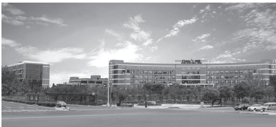
浙江正泰中自控制工程有限公司总部
