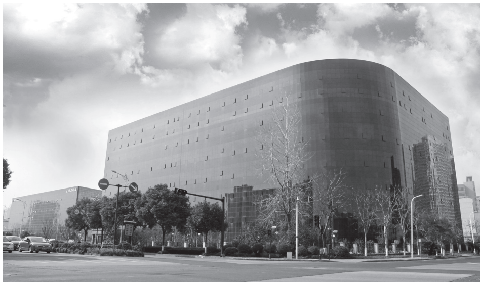
位于杭州滨江的正泰太阳能公司总部
